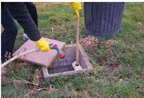
Nettoyage périodique des regards de visite
