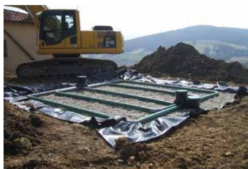
Travaux de réalisation d'un filtre à sable
